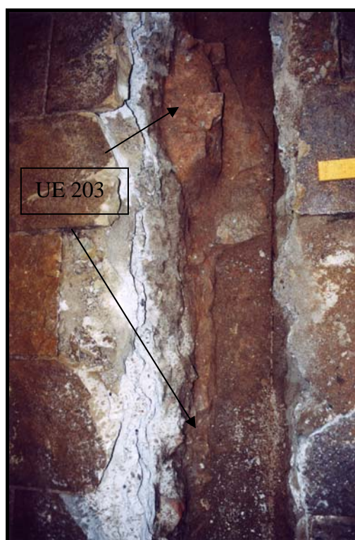
Foto 6. Restes de la UE 203. A la dreta de la imatge s'observa la canalització elèctrica present a tota la rasa.
