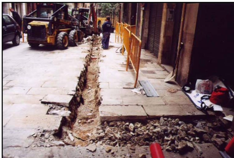
9. Màquina realitzant els treballs de buidat de la rasa al tram 4 un cop extret el paviment de lloses.
