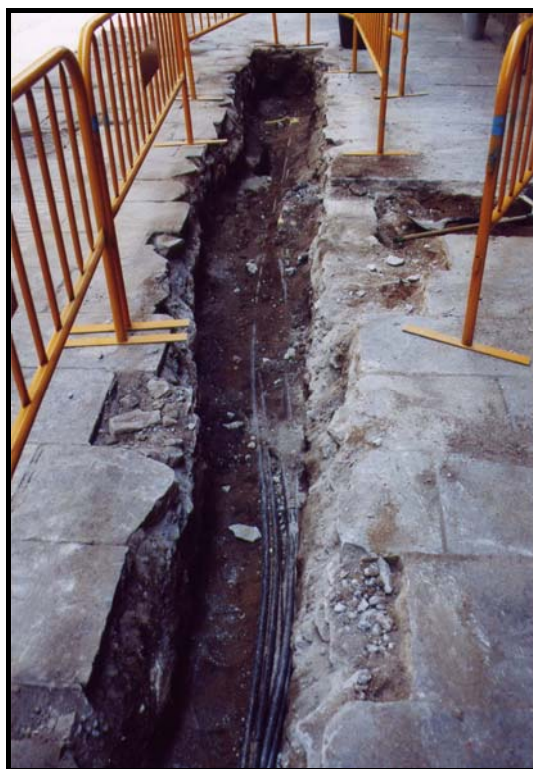
10. Rasa corresponent al tram 4. Es pot observar la presència de cablejat elèctric a poca profunditat.
