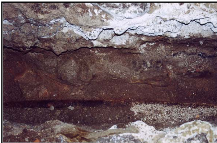
Foto 3. Al centre de la imatge, restes del mur UE 203. Es pot observar el servei a tocar de l'estructura.
