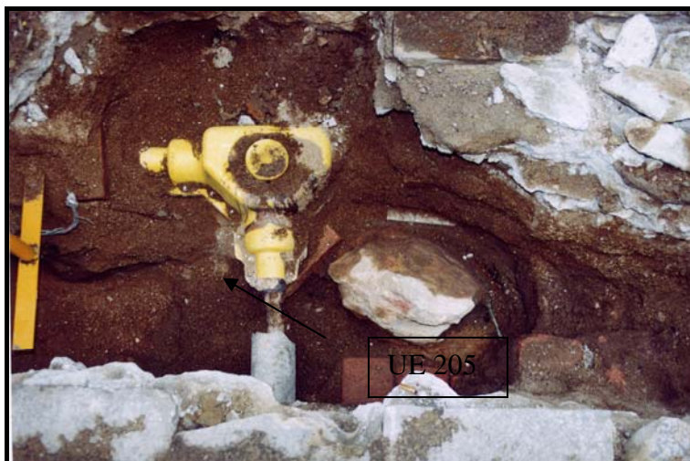
Foto 5. Al centre de la imatge, restes de la UE 205. Es pot observar la gran quantitat de serveis que l'envolten.
