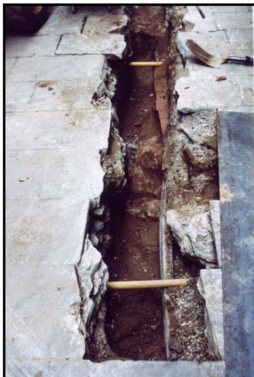
Foto 8. Restes de la UE 300 situada al tram 3 de la rasa. S'observa la gran quantitat de serveis que la fragmenten.
