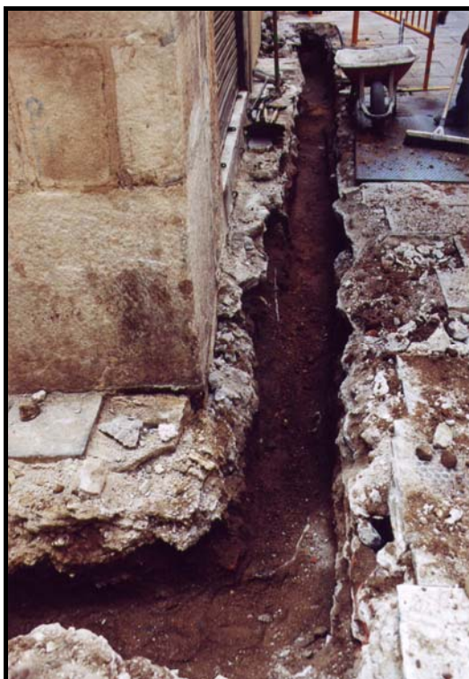
1. Xamfrà dels carrers Trompetes i Agullers. Tram 1 de la rasa un cop buidat. S'observa la presència de serveis.
